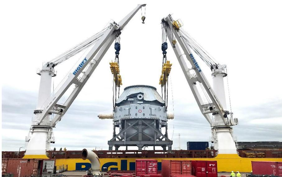
330-тонный LD-конвертер (кислородный конвертер) производства Primetals Technologies загружается на борт судна Harry River в порту г. Роттердам
