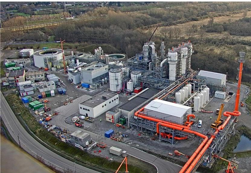
Die Steelanol-Anlage befindet sich in der Nähe des integrierten Stahlwerks von ArcelorMittal in Gent. Die orangefarbenen Rohre auf dem Foto führen vom Stahlwerk direkt zur Steelanol-Anlage.
