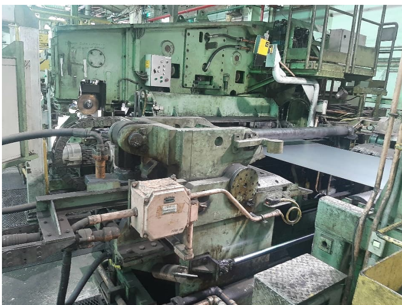
Seitenansicht der Schweißmaschine im Stahlwerk in Ipatinga.
