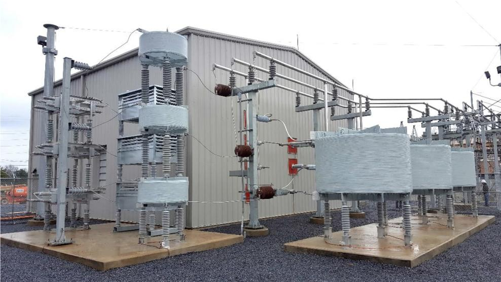
Primetals Technologies wird den branchenweit ersten statischen 69-kV-Synchronkompensator (STATCOM) an das Gerdau-Werk in Petersburg, Virginia, USA, liefern. Das Bild zeigt einen 34,5-kV-STATCOM, der kürzlich für Gerdau in Cartersville, Georgia, USA, implementiert wurde.
