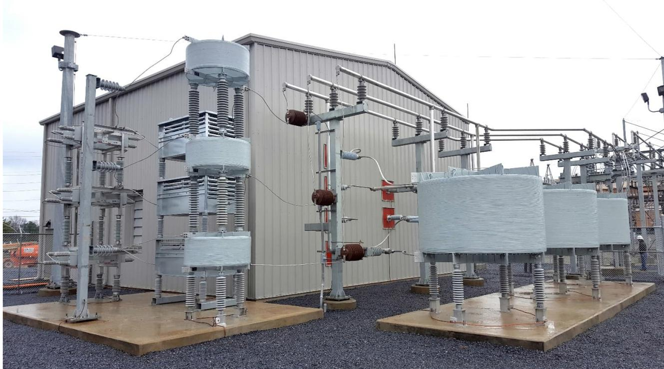
プライメタルズ テクノロジーズは、米国バージニア州ピーターズバーグにあるゲルダウの工場に、業界初となる 69kV の自励式無効電力補償装置 (STATCOM) を納入します。(写真は、ゲルダウの米国ジョージア州カーターズビルにある工場に最近納入した 34.5kV の STATCOM)
