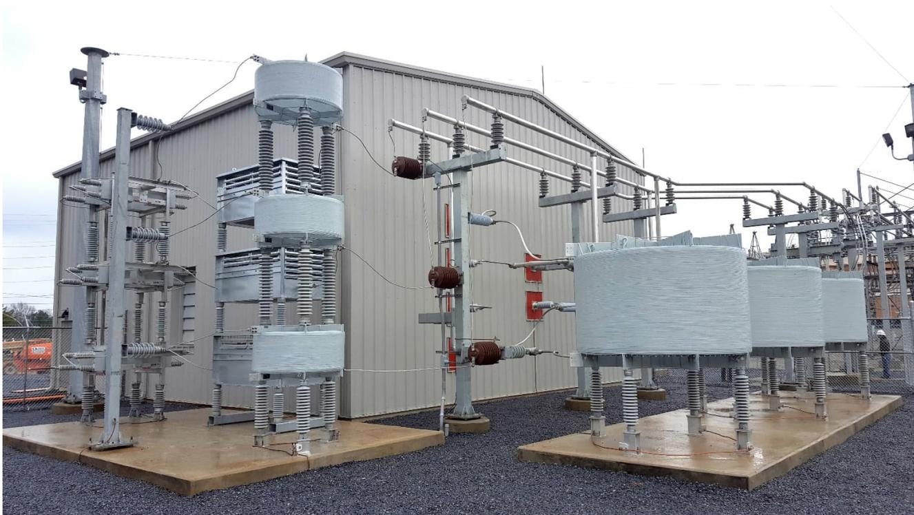
A Primetals Technologies fornecerá um compensador síncrono estático (STATCOM) de 69 kV, o primeiro da indústria siderúrgica, para a usina da Gerdau em Petersburg, Virginia, EUA. Na foto, um STATCOM de 34,5 kV fornecido recentemente pela Primetals Technologies para a usina da Gerdau em Cartersville, Georgia, EUA.
