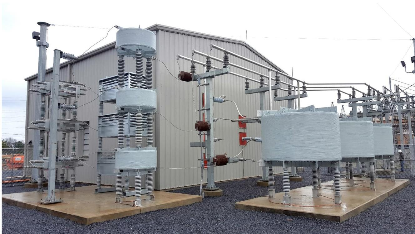
Primetals Technologies поставит первый в истории отрасли статический синхронный компенсатор мощностью 69 кВ для завода Gerdau в Питерсберге, штат Вирджиния, США. На фото статический синхронный компенсатор мощностью 34,5 кВ, недавно поставленный Primetals Technologies компании Gerdau для ее завода в г. Картерсвилл, штат Джорджия, США.
