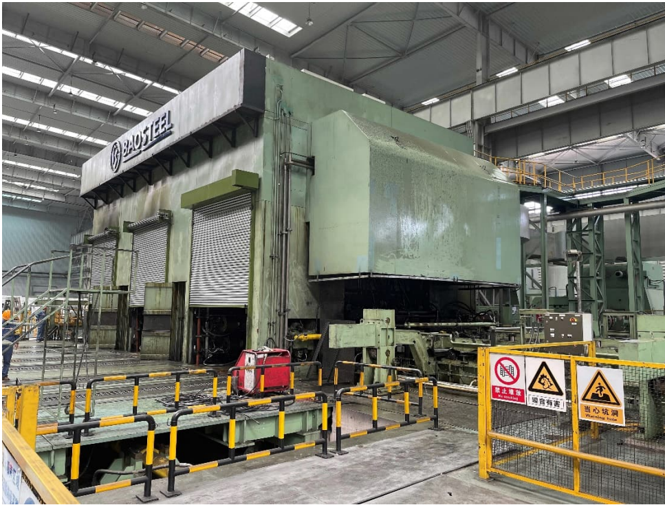
Aktuelles 3-Stand-Fertigwalzwerk von Baowu Aluminium.
