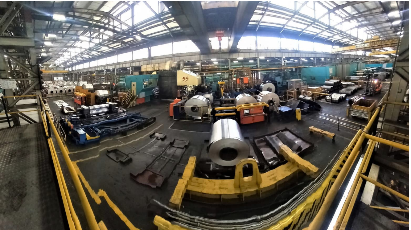
Vista do laminador a frio S5. A Primetals Technologies modernizará o laminador através da instalação de indutores de aquecimento de borda.
