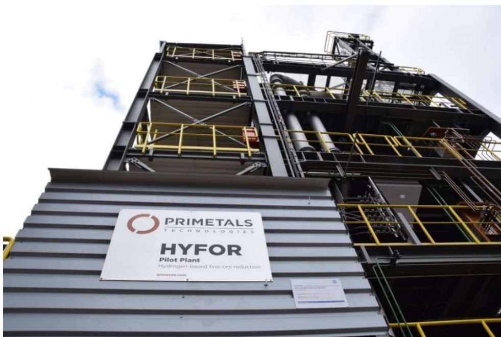
Революционная установка HYFOR от Primetals Technologies в Донавице.
