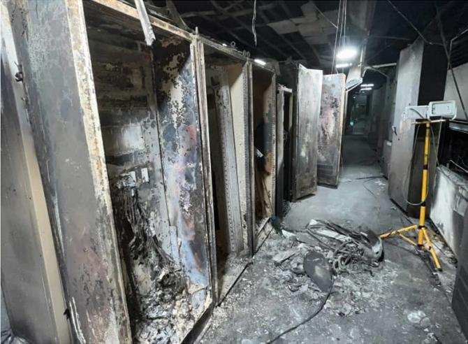
大型棒材轧机电气自动化室内的所有设备都因火灾而严重受损。
