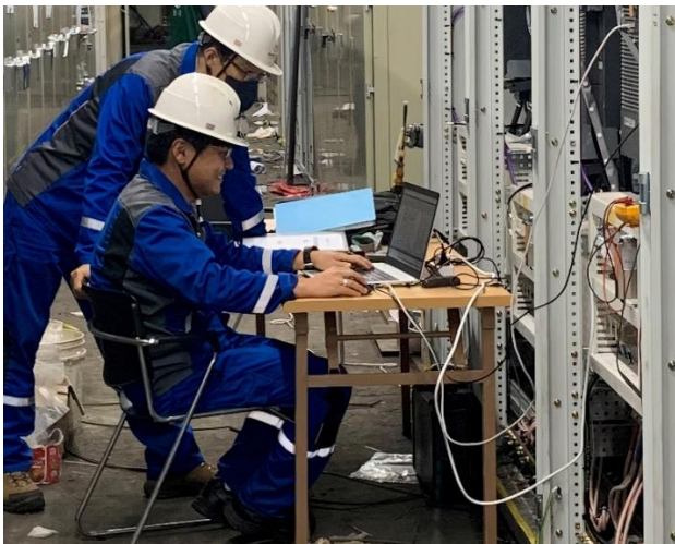
セア ベスティールでドライブ装置を設置するプライメタルズ テクノロジーズのエンジニア
