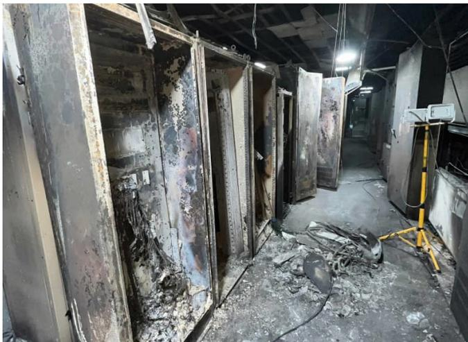
O incêndio danificou todos os equipamentos da sala de elétrica e de automação do grande laminador de barras.
