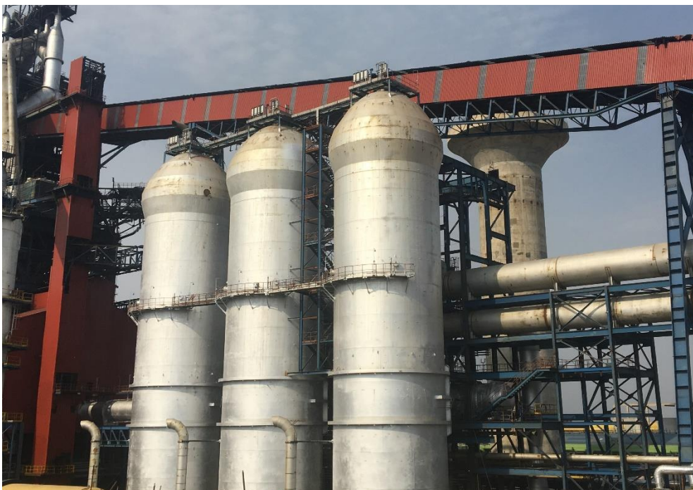
インドに建設されたプライメタルズ テクノロジーズ製内燃式炉
