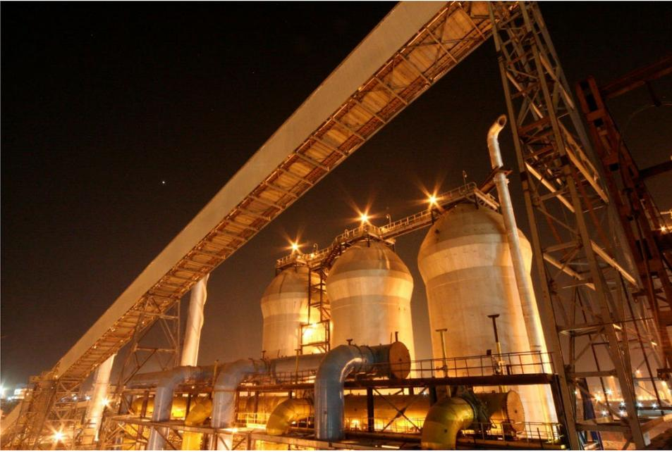
普锐特冶金技术在印度建设的内燃式热风炉。
